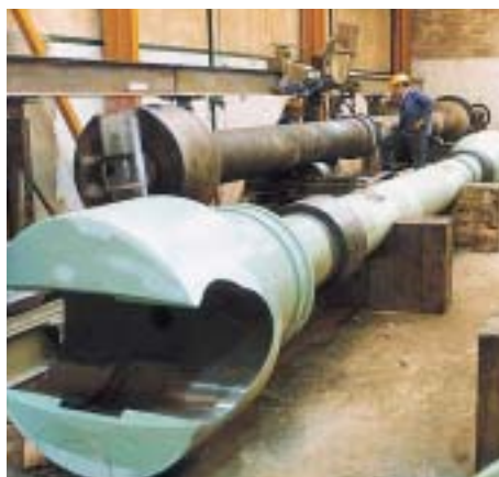
Reparación de ejes de accionamiento. Spindles fixing.
